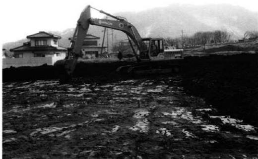
重機作業風景
