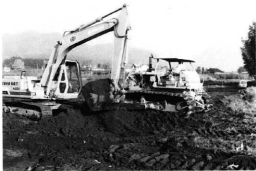
重機作業風景
