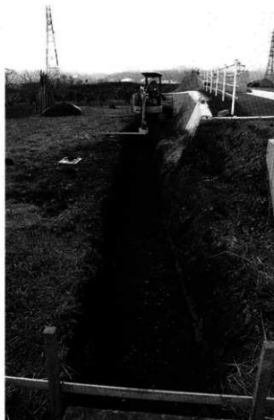
写真3 A区延長部工事実施状況（北東より）
