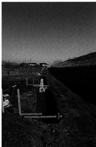
写真4 B区延長部工事実施状況（南西より）
