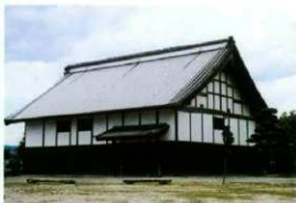
お台所の建物 唯一残る龍岡城の建物
