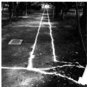
管路第2トレンチ
