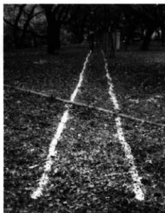
管路第1トレンチ
