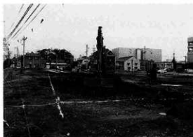
写真1 A区重機による表土剥ぎ
