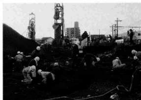
写真3 大型建設機械の迫る中...
