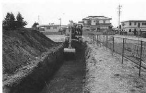
写真2 トレンチ調査
