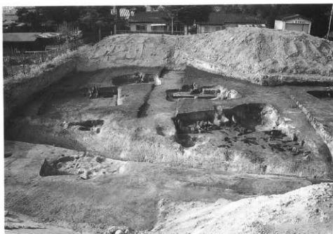
写真6 竪穴住居址と堀跡
