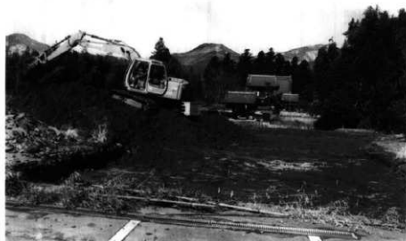
重機作業風景
