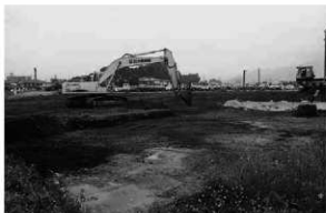
B区表土除去（南東から）
