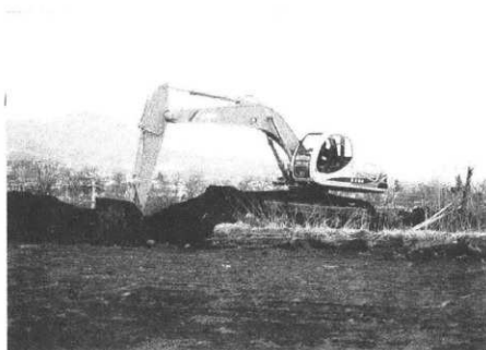
バックホーによる表土除去作業
