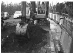
B区 重機による掘削
