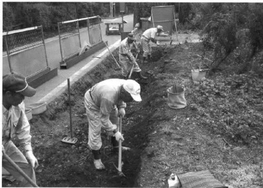
A区作業風景
