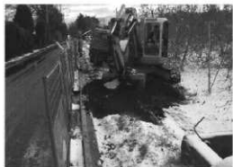
D区 重機による掘削
