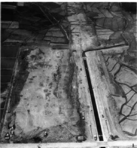
1. 借馬遺跡A地区北部全景及び農具川 河川改良工事状況(南方より)
