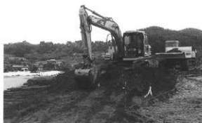
重機による表土剥ぎ
