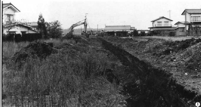
1. トレンチ調査 (南から)
