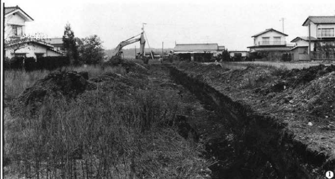
1. トレンチ調査 (南から)
