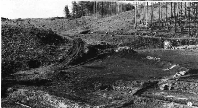
3. 北調査区近景 (南から)
