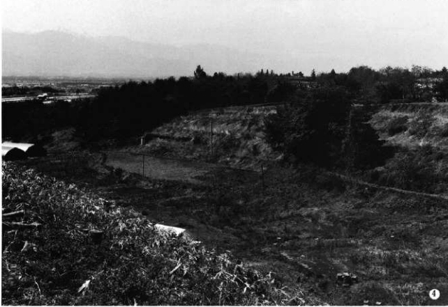
4. 遠景(南東から)
