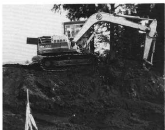
2 重機による表土はぎ
