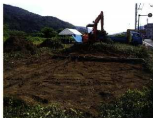
バックホーによる表土除去
