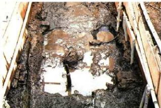
B2検土坑2 (西から撮影)
