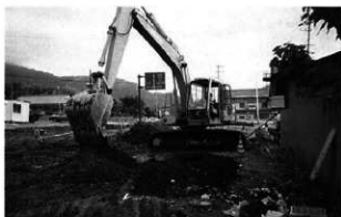
TP3検出状況 (北より)
