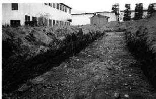
1号トレンチ検出状況 (南より)
