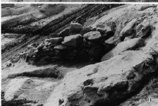
石室構築掘り方 12：石室及びその裏込め状況 13：裏込め除去後の石室と掘り方
