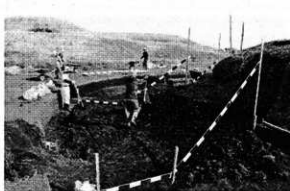
古墳復元工事作業風景
