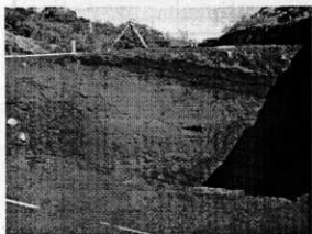
B-1区南北方向土層断面 (西から)
