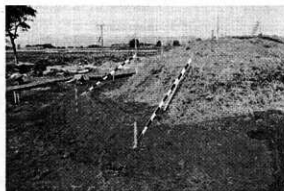
古墳復元工事途中経過
