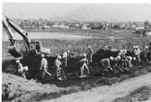
検出作業風景
