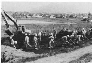
検出作業風景
