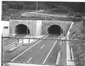
開通まもない長野道明科トンネル
