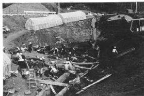
排土保護工事
