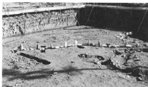
排水管による水路の切り直し
