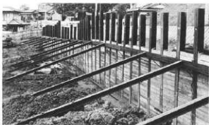
生活道路保護のための土留め矢板
