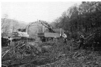
◀ 樹木かたづけ 重機による表土はぎ
