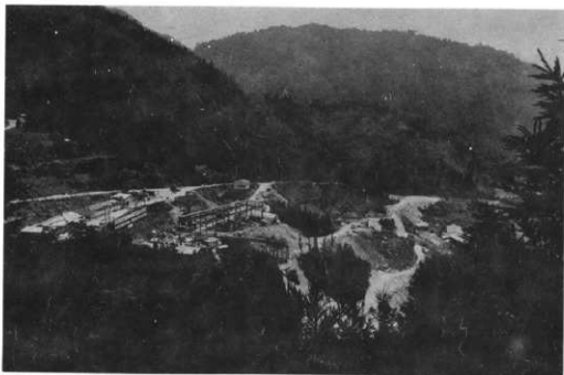
6. 第1期斜坑口工事場
