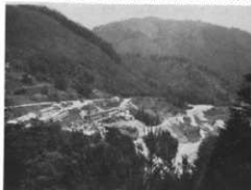
調査現場と斜坑口
