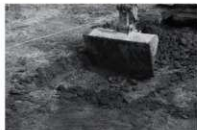
重機による表上の掘削
