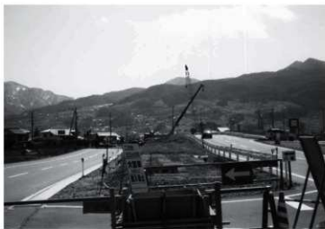
佐野川橋梁の工事(平成16年)
