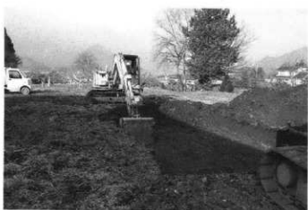
トレンチ掘削状況 (東より)
