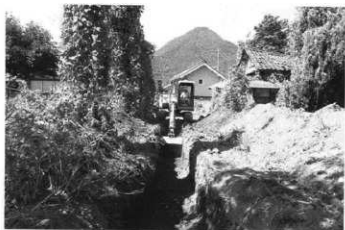
トレンチ掘削状況 (東より)
