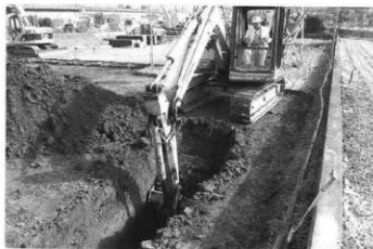
トレンチ掘削状況 (西より)
