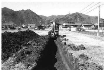
トレンチ掘削状況 (東より)
