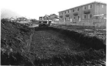
トレンチ検出状況 (西より)
