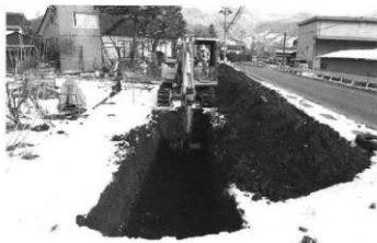
トレンチ掘削状況 (西より)
