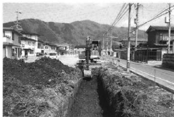
1号トレンチ掘削状況 (南より)
