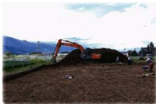
重機による表土剥ぎ
