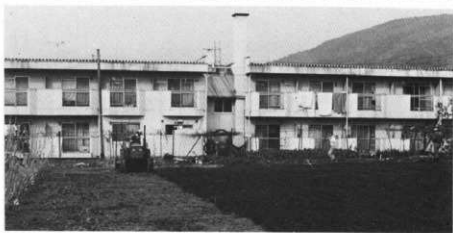
埋め戻し作業
