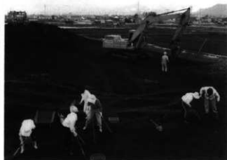
2. 表土削き作業
