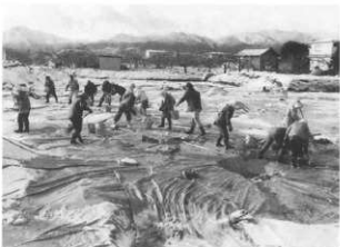
第5写真 2-1区での除染作業
