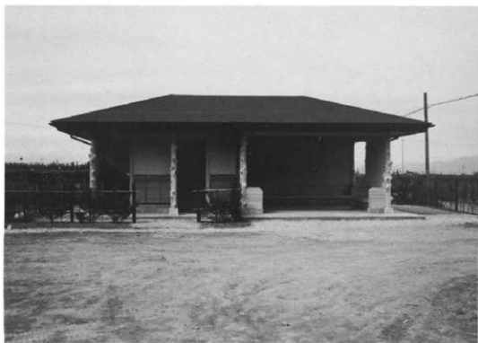
休憩所・便所
