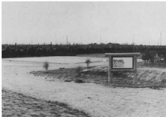
土盛り工事（遊歩道・有明砂舗装）
