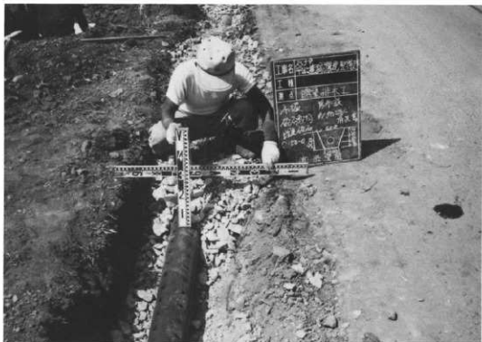
暗渠排水工事
