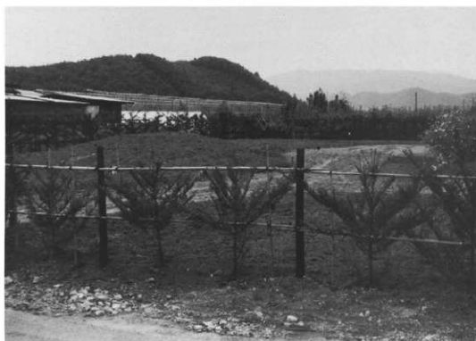
土盛り工事（築山部分）
