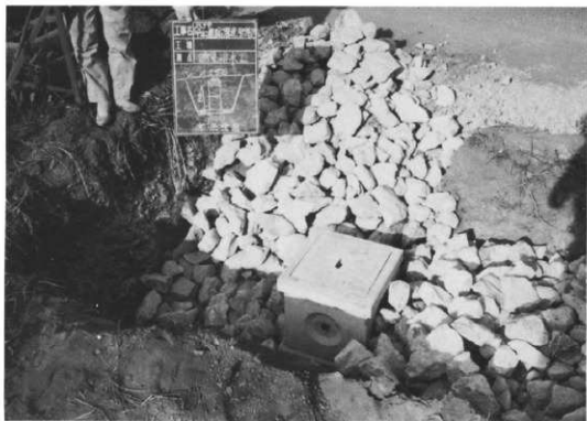
浸透槽設置工事
