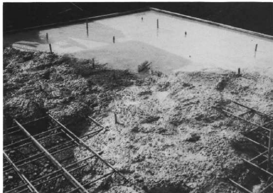
第 62 号復原住居基礎工事
