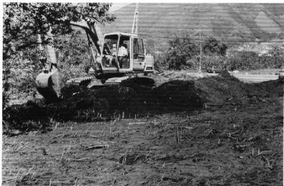
写真4 重機による表土除去作業
