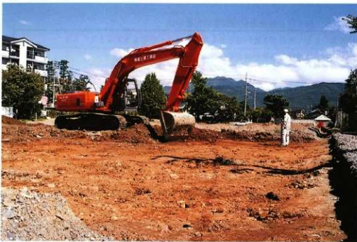
重機による表土除去
