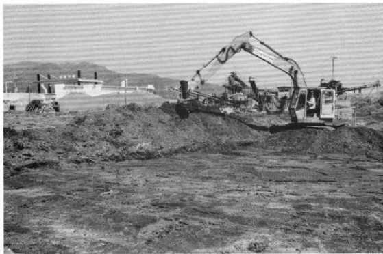
写真3 重機による表土除去（千曲川洪水による土砂が堆積している）
