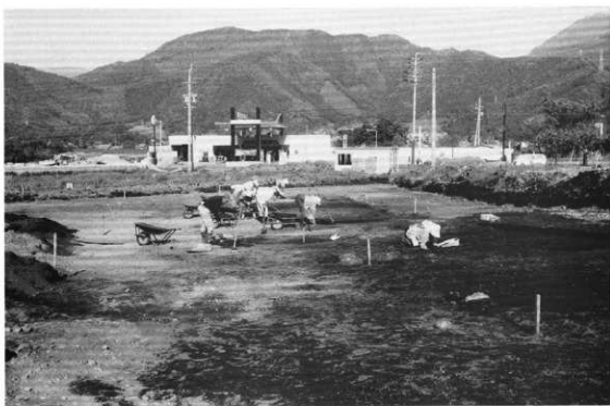
写真22 0地点調査風景
