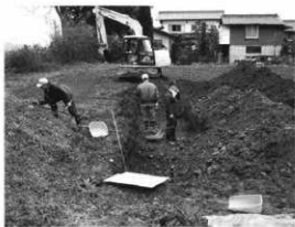
Aトレンチ調査風景
