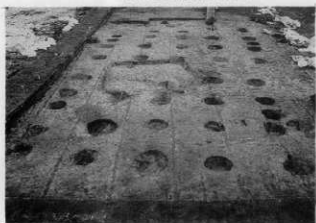
2・3号掘立柱建物址完掘状況(東より)
