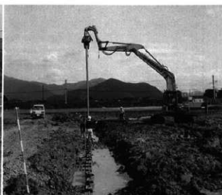
止水用鋼矢板の敷設
