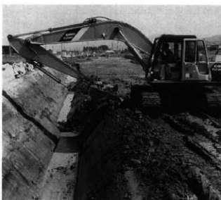
重機による法面の掘削
