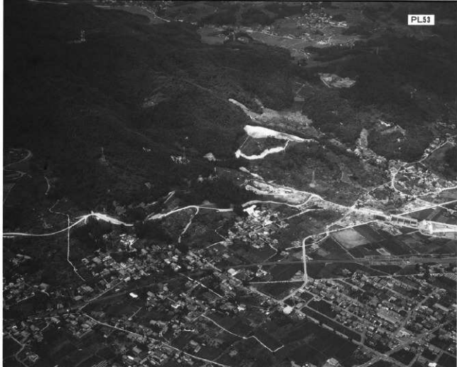
空撮遠景(南東から)
