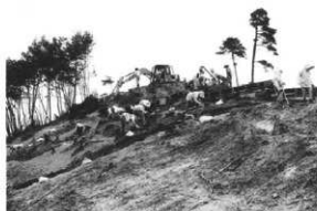
斜面部作業風景(平成3年6月)
