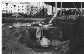
実測風景 (平成3年5月)
