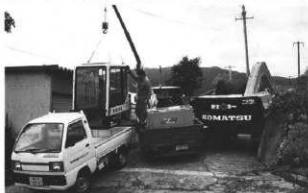
重機の導入 (平成元年9月)
