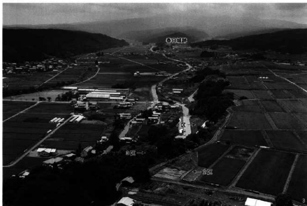
3:天神城調査区 遠景(北より)
