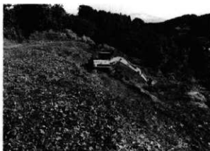
重機による道の確保(奥)と表土剥ぎ(前)
