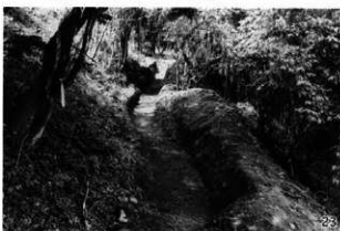
22:16トレンチ 断面 23:18トレンチ 完掘
