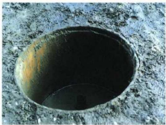
桶の底に穴をあけ、竹管を設置した井戸。水圧により竹管から噴水させて、桶の側面から竹管により配水するもの。
