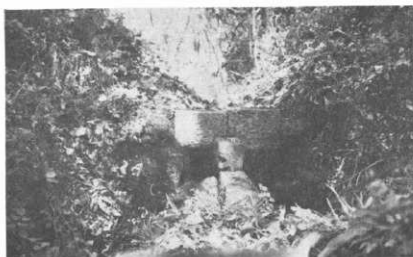
第1図 田上堰・鳴沢山分水口
