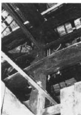
写真2 「美麻村中村家住宅」 「中村家住宅修理工事報告書」 より転載
