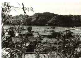
⑤新城(1005)北からの遠景
